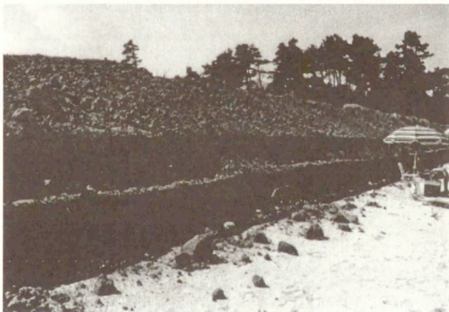
Fot. 2. Stabilizacja brzegu wydmowego na zachód od Jastrzębiej Góry – gabiony i nasyp ziemny (fot. M. Przewoźniak)
