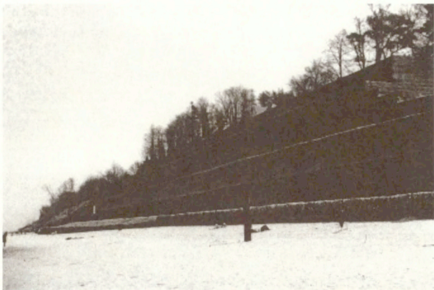
Fot. 1. Techniczna zabudowa klifu w Jastrzębiej Górze – wysokość umocnień 30 m. (fot. M. Przewoźniak)
