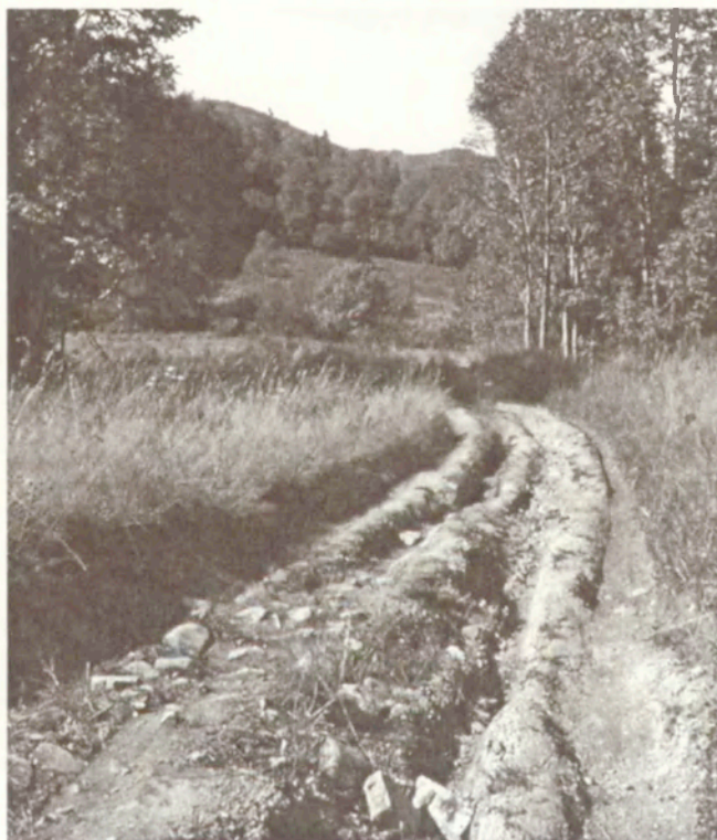
Fot. 2. Fragment sporadycznie użytkowanej przedwojennej drogi prowadzącej na Przełęcz Przysłup - widoczna intensywna erozja liniowa w głębokich koleinach
