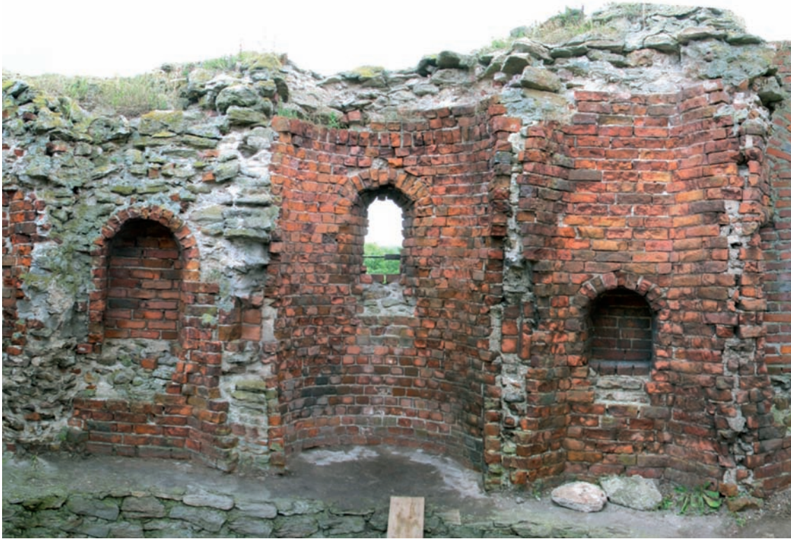
Ryc. 7. Obudowana cegłą apsyda wschodnia na ostatniej kondygnacji wieży i przyległe do niej nisze liturgiczne (fot. M. Auch)
