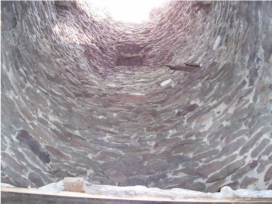
Ryc. 2. Wieża w Stołpie od strony wewnętrznej: widok na środkową i górną kondygnację (fot. A. Buko) Fig. 2. The tower in Stołpie from the inside: the view of the middle and upper storeys (photo: A. Buko)
