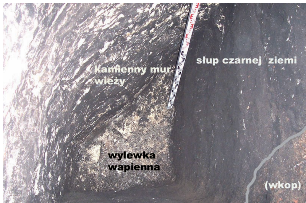
Ryc. 6. Najniższa (zasypana ziemią) kondygnacja wieży od wewnątrz: wylewka zaprawy wapiennej w spągu najniższej kondygnacji (fot. T. Dzieńkowski)
