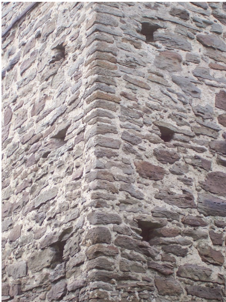
Ryc. 5. Materiał budowlany i wążek muru wieży w Stołpie (fot. A. Buko)
