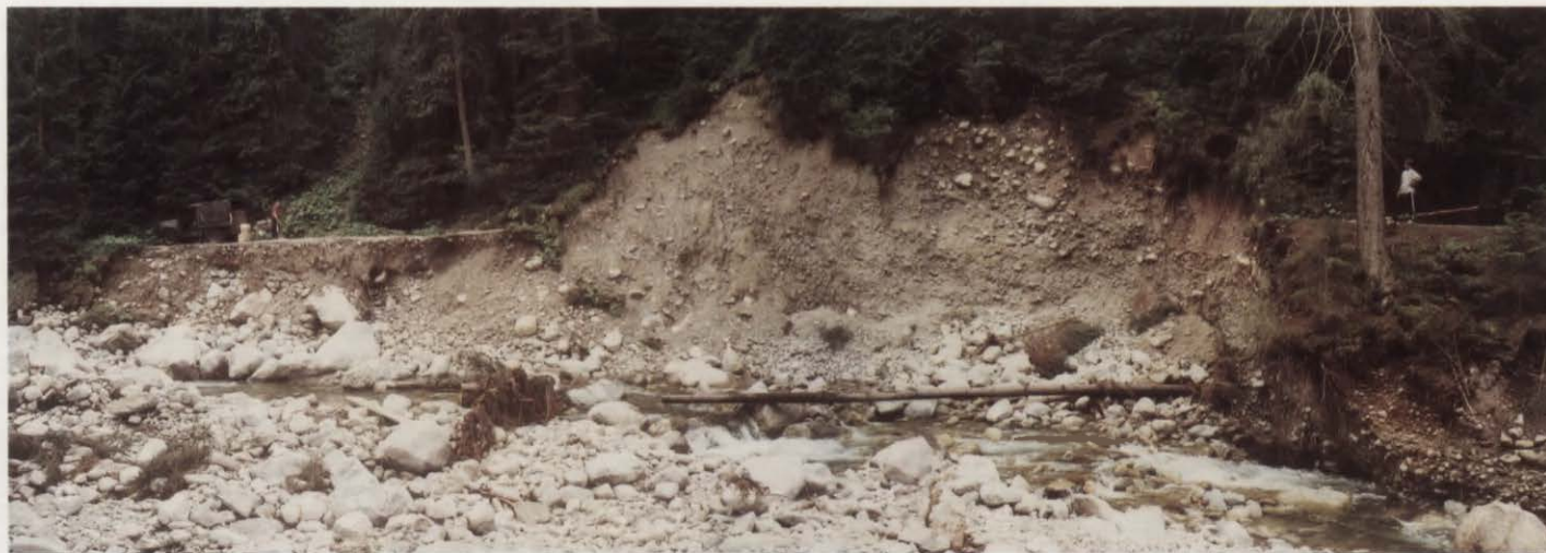
Fot. 9. Podcięcie erozyjne wzdłuż drogi jezdnej z Brzeziny do Hali Gąsienicowej. 30-metrowy odcinek całkowicie zniszczony. Kubatura utworzonej formy wynosi około 1200–1400 m 3
