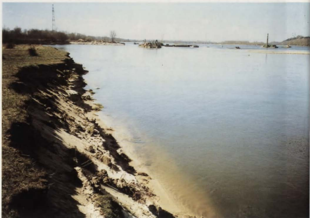
Fot. 5. Zróżnicowane wysokościowo i geologicznie erozyjne brzegi Wisły w Wyszogrodzie. Na drugim planie prace przy budowie filarów nowego mostu drogowego i słupy linii energetycznej 110 kV. Widok z mostu drewnianego – w dół rzeki. 08.04.1997
