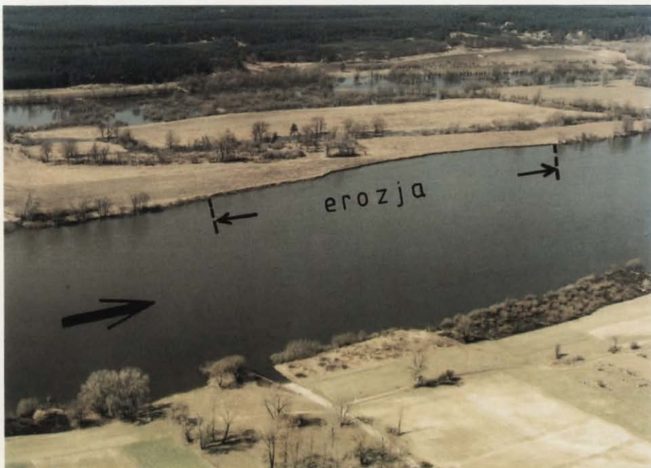
Fot. 20. Erodowany od 6 lat lewy brzeg Wisły uregulowanej w Brzozie Toruńskiej. Wysokość brzegu 4 m, zbudowanego z piasków przykrytych pyłami. Stan rzeki około 2 m wyższy od średniego. 16.04.1996
