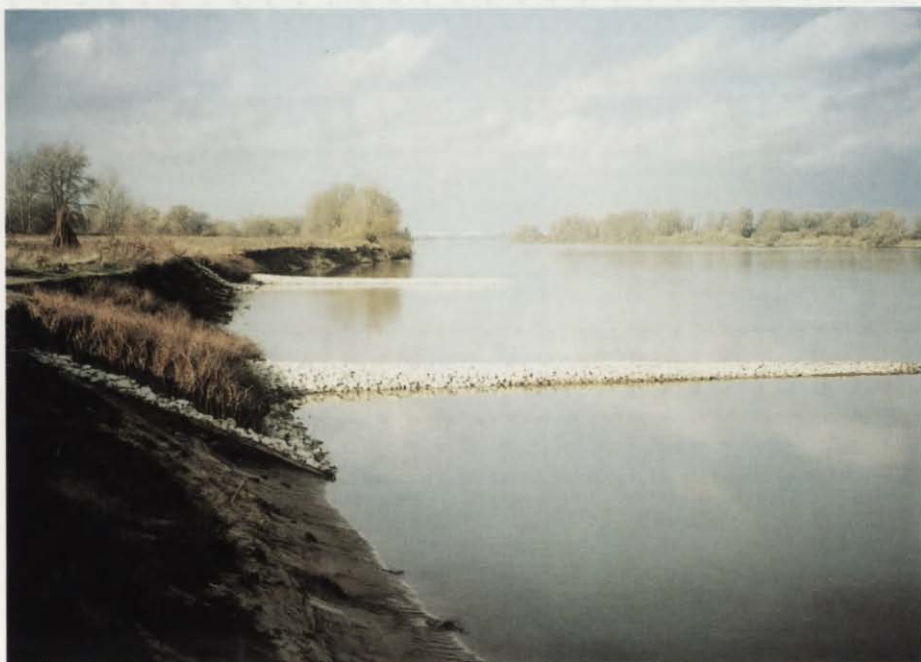
Fot. 21. Świeżo zabudowany dwiema ostrogami erozyjny odcinek w Brzozie Toruńskiej. 04.11.1996
