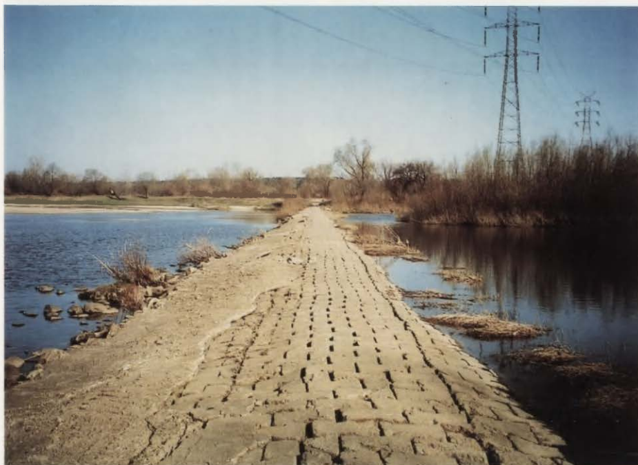
Fot. 8. Przetamowanie ramienia Wisły w przebiegu linii energetycznej 400 kV przez Kępę Semplawską. 08.04.1997
