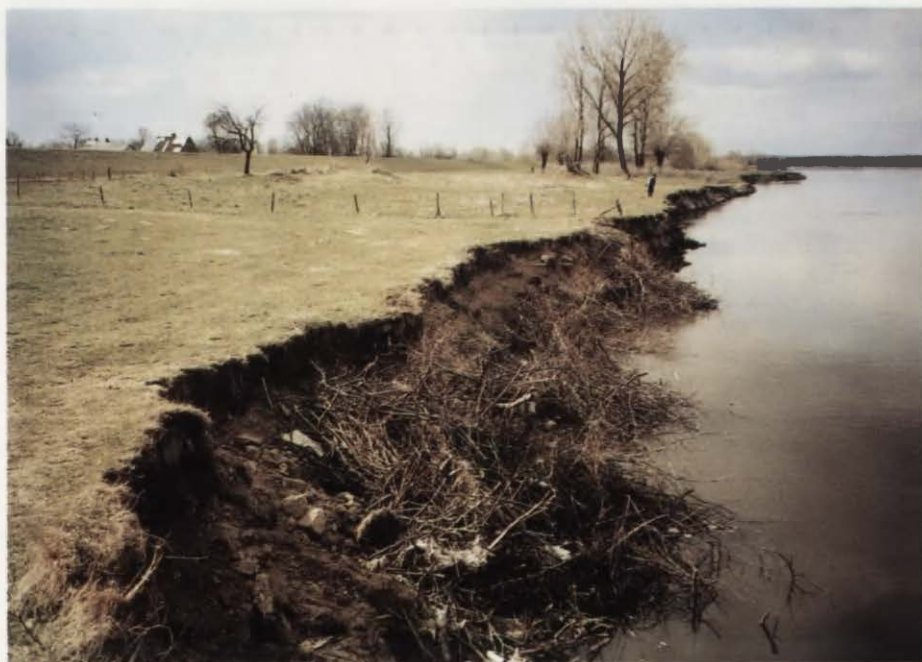
Fot. 13. Erozyjny brzeg (lewy) w Kępie Karolińskiej (tab. 10). Od brzegu do podstawy wału 60 m. Brzeg budują aluwia pylaste. 21.04.1997
