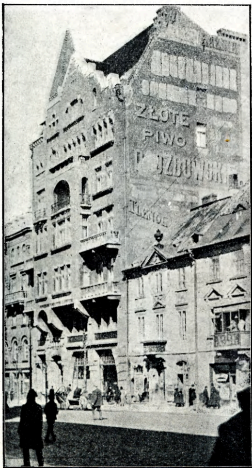
Fig. 3. Współczesny dom wielopiętrowy obok domu z czasów Stanisława Augusta, w Warszawie przy ul. Krakowskie Przedmieście. Przykład ujemny otoczenia zabytku.
