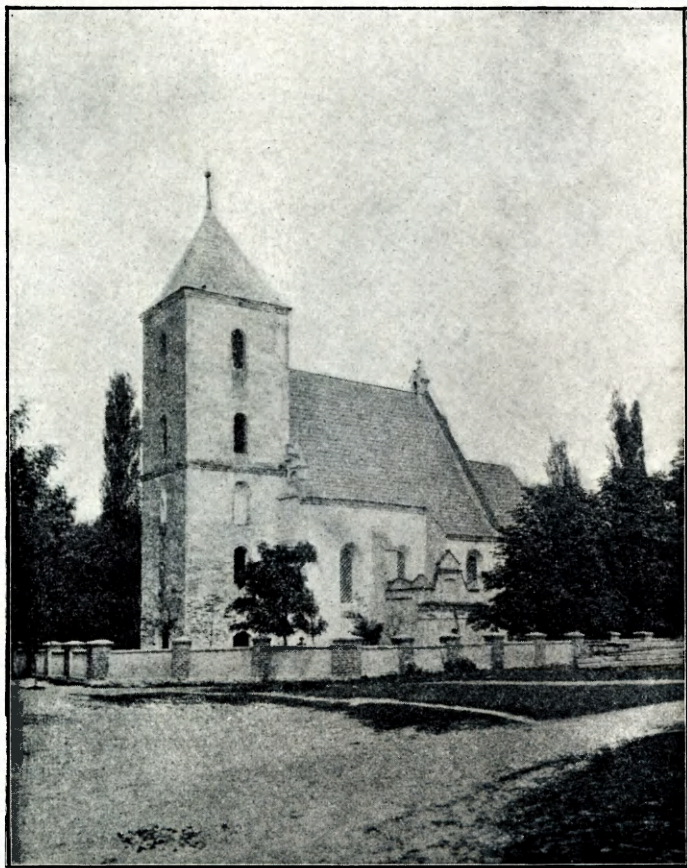
Fig. 7. Kościół paraf. w Chojnem przed przebudową wieży.
