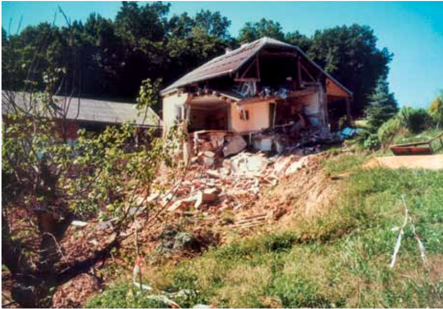
Fotografia 2.17. Osuwisko rynnowe w Gorlicach powstałe po opadach ulewnych na początku czerwca 2010 roku
