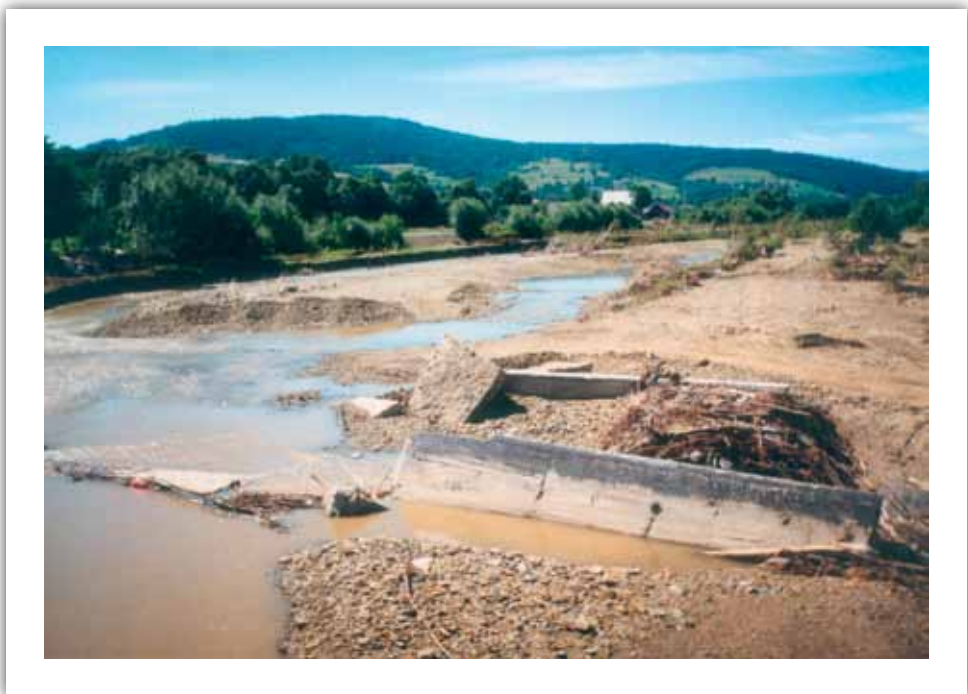
Fotografia 4.13. Koryto roztokowe Paleczki, dopływu Skawy; częściowa regulacja w rejonie mostu została zniszczona w czasie wezbrania w lecie 2001 roku
