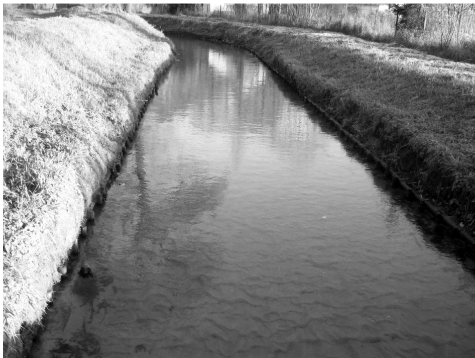
Ryc. 1. Rzeka Stobrawa po poszerzeniu i umocnieniu brzegów (fot. A.Sałdak) The Stobrawa river after widening and strengthening of riverbanks
