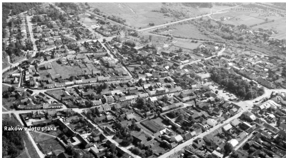
Ryc. 7. Raków z lotu ptaka; zwarta zabudowa w otoczeniu rynku widoczna po prawej stronie zdjęcia
