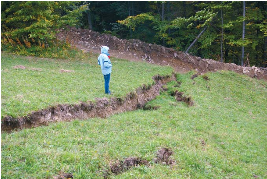
Fot. 4. Odmłodzona dolna część starego osuwiska powstałego w 2008 r. w zlewni potoku Jamne
