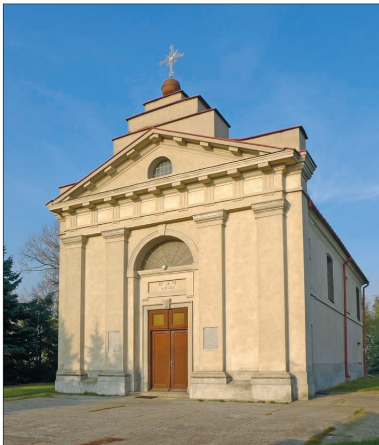
Ryc. 21. Osmolin, kościół parafialny (1791). Fot. R. Mączyński
