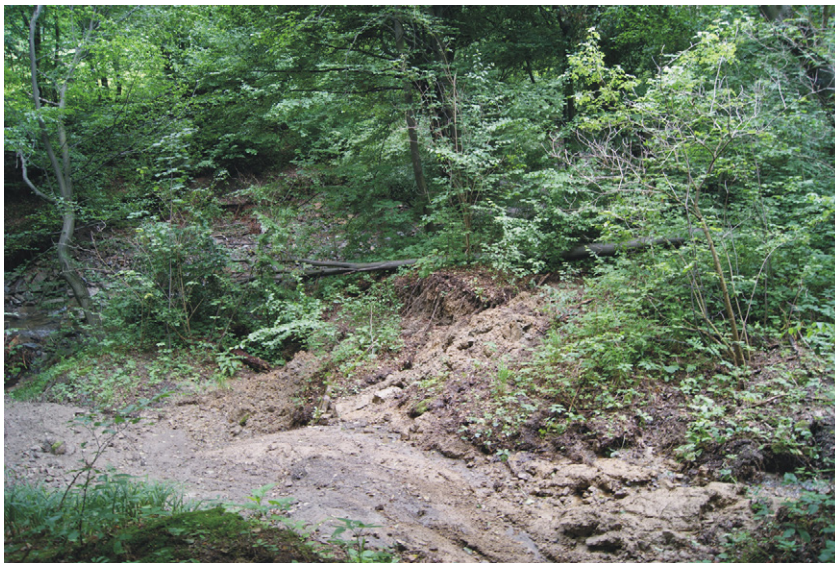
Fot. 1. Osuwisko przykorytowe uaktywnione po opadach w maju i czerwcu 2010 r. Photo 1. Landslide near Bystrzanka channel activated after rainfall in May and June 2010
