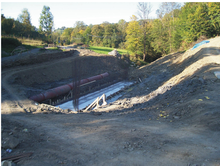
Fot. 2. Budowa mostu na Bystrzance w 2009 r. powodująca dostarczenie luźnego materiału do koryta. Materiał został wyniesiony podczas wezbrań w 2009 i 2010 r. Photo 2. Construction of a bridge over the Bystrzanka stream in 2009, causing delivering of loose material into the riverbed. Material transported during floods in 2009 and 2010.
