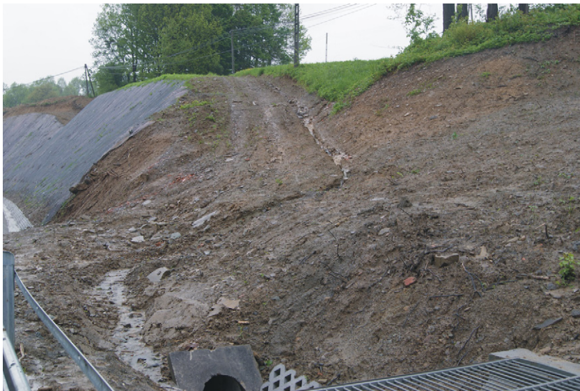
Fot. 12. Geomorfologiczne skutki opadów w 2010 r. na drodze nieutwardzonej w dolinie Bystrzanki
