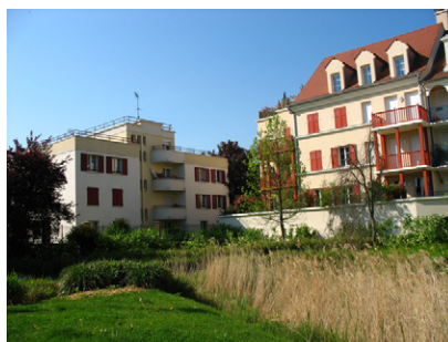
Fot. 26. Odnowiony budynek socjalny (po lewej stronie) i nowy budynek wielorodzinny (po prawej), cité-jardins haute Refurbished social housing (on the left) and new multi-family housing (on the right), cité-jardins haute
