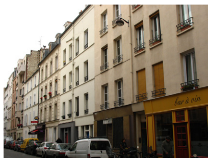
Fot. 14. Niska zabudowa w stylu dawnego przedmieścia (rue Pernety) Low buildings in the style of the old suburbs (street Pernety)
