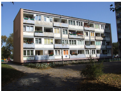
Fot. 3. Budynek komunalny przy ul. Marymonckiej Municipal building at Marymoncka street
