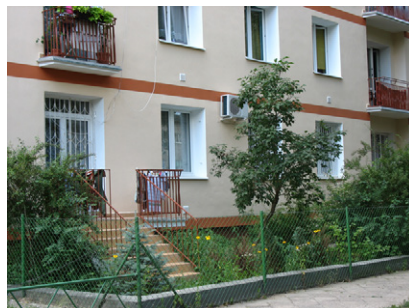
Fot. 4. Przykład odnowionej fasady Example of refurbished facade
