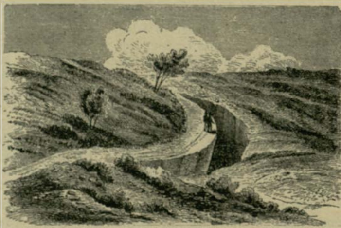
Widok przedstawiający szparę w gruncie po silnem trzęsieniu ziemi.
