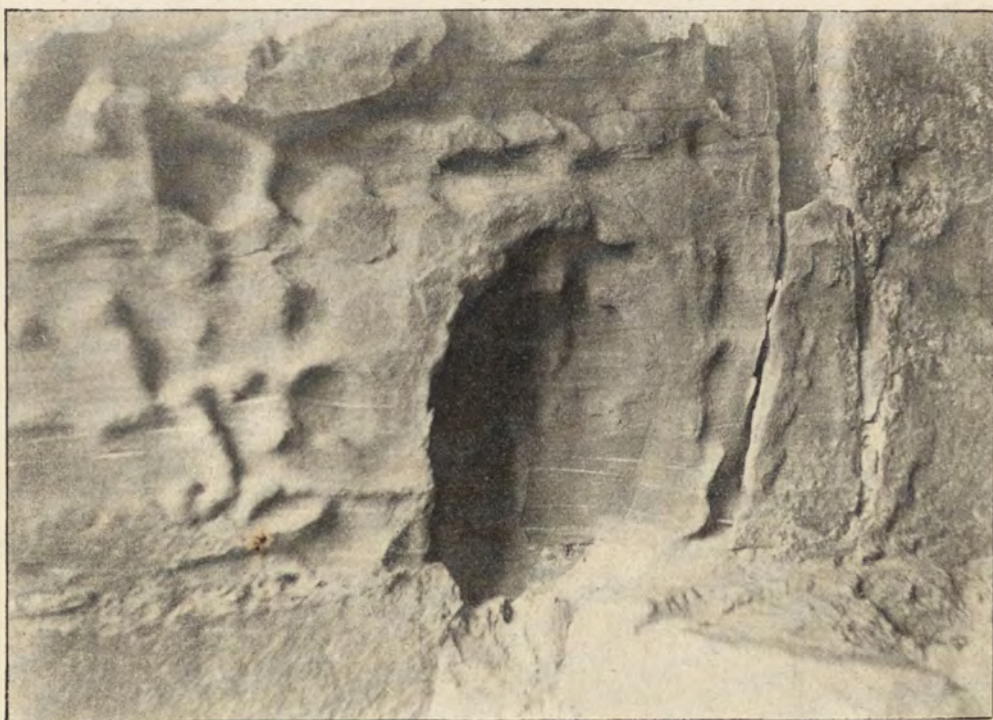
Dziura wywiercona przez wiry powietrzne przy udziale piasku w ociosanym piaskowcu zamku heidelberskiego.
