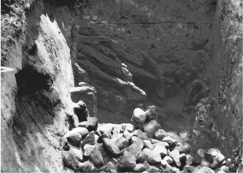
Ryc. 15. Jarantów. Szczątki konstrukcji drewnianej i kamiennej w wykopie sondażowym.
