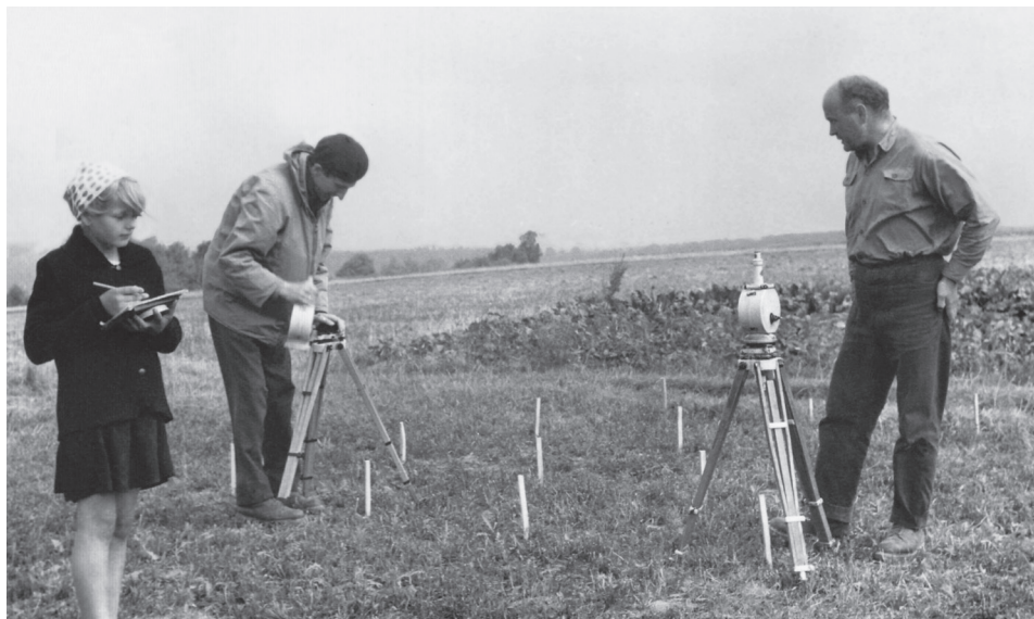
Ryc. 1. Nowa Słupia 4. Badania geofizyczne przy użyciu wagi magnetycznej, wykonywane przez J. Kowalczuka (w środku) i T. Stopkę (po prawej).
