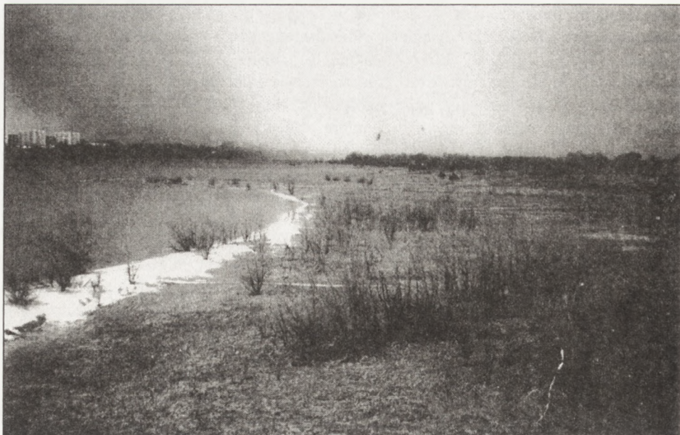
Fot. 2. Nowo tworzony, prawobrzeżny poziom zalewowy poniżej mostu drogowego we Włocławku w formie odsypu brzegowego porośniętego trawą i krzewami, uniemożliwiający funkcjonowanie portu zimowego
