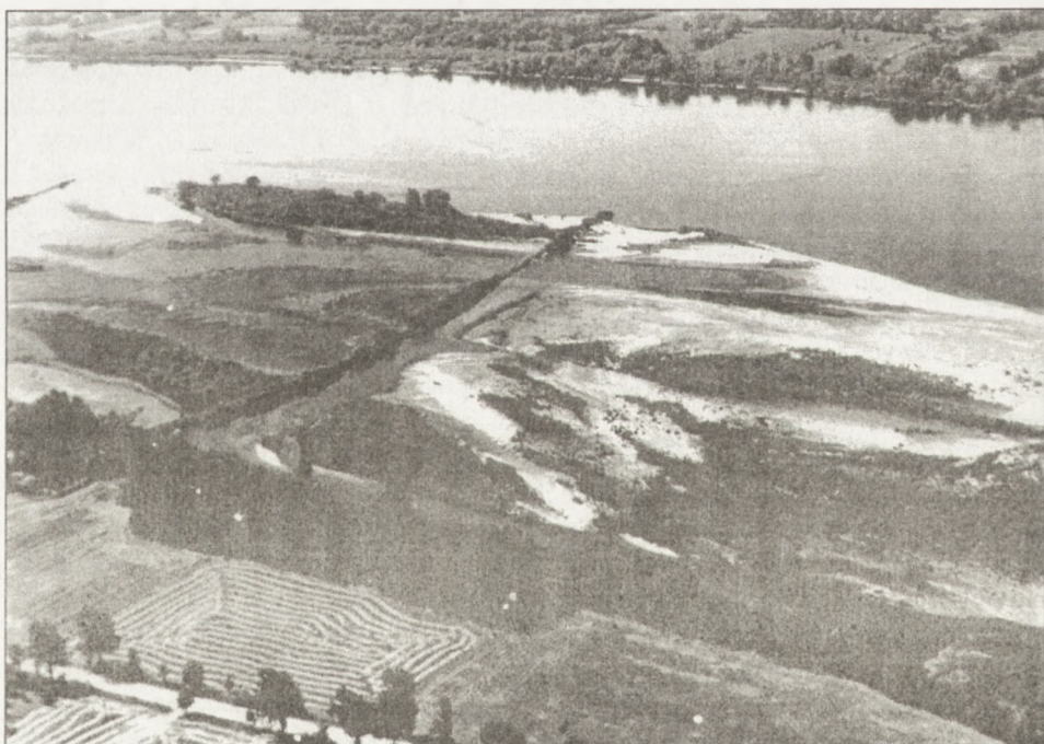
Fot. 4. Faza inicjalna nowego poziomu zalewowego pod Bobrownikami (lipiec 1988)
