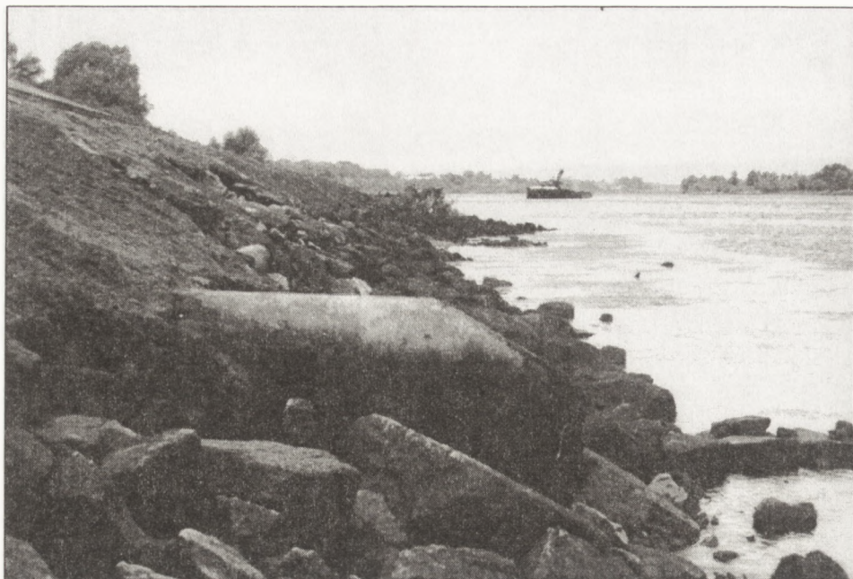
Fot. 10. „Zawieszono” rury kolektora deszczowego we Włocławku
