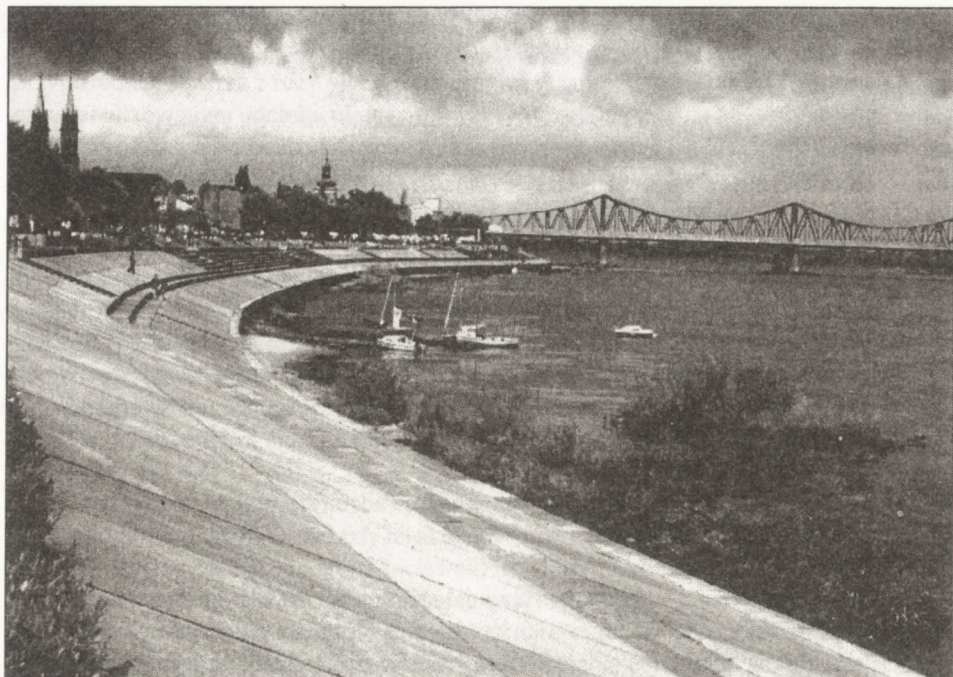
Fot. 6. Brzeg bulwaru wrocławskiego podczas trwania stanów średnich niskich
