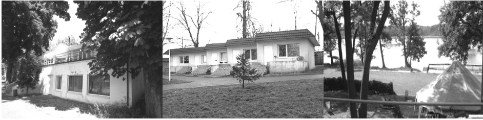
Fot. 2. Zabytkowe założenie pałacowo-parkowe w Lusowie wtórnie podzielone i zdegradowane współczesną zabudową ośrodka wypoczynkowego (fot. M. Szczepańska).
