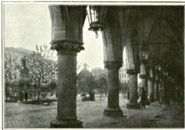
Krakau: Blick von den Arkaden der Tuchhalle auf den Ringplatz und das Adalbertskirchlein.
