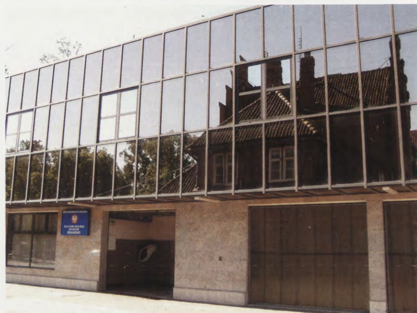
Fot. M. Łajtar. Braniewo – kolejowe przejście graniczne
