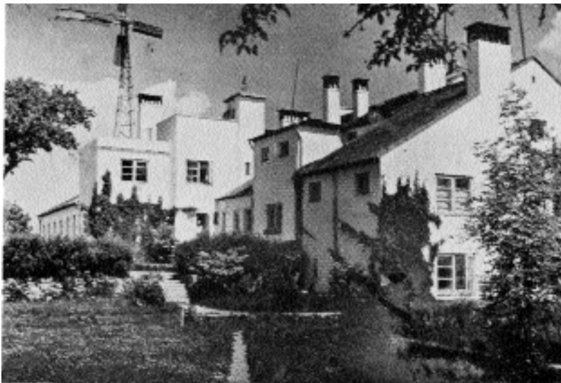
Budynek główny Stacji Hydrobiologicznej na Wigrach
