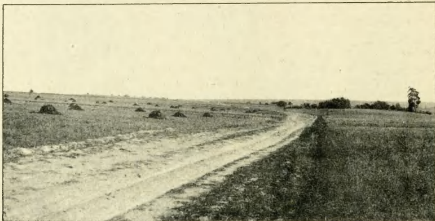
Ryc. 76. Droga nieumocniona, gruntowa.
