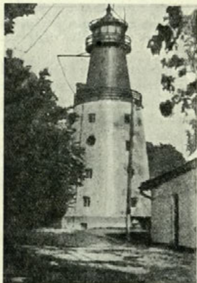
Ryc. 220. Latarnia morska im. Stefana Żeromskiego na Przyładku Rozewskim
