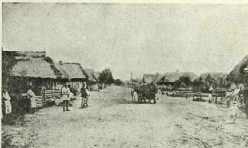
Ryc. 163. Wieś na Polesiu. Zauważ domy rozłożone po obu stronach szerokiej ulicy.
