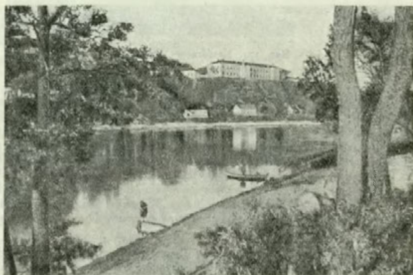
Ryc. 173. Grodno nad Niemnem. Zamek królewski.
