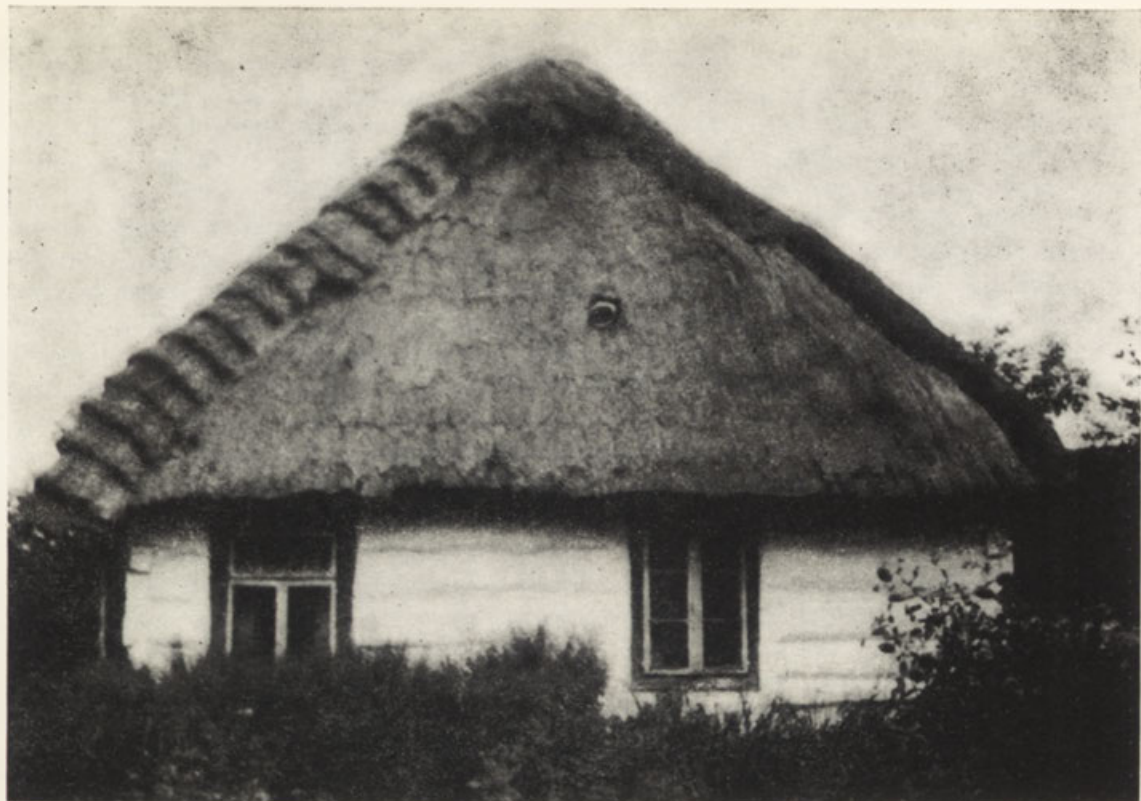
Fot. 5. Wieś Bronisławka. Dom zbudowany w 1883 r. z bali rżniętych, dach czterospadowy o niskim okapie, okna większe w porównaniu z chatą budowaną przed 1864 r.
