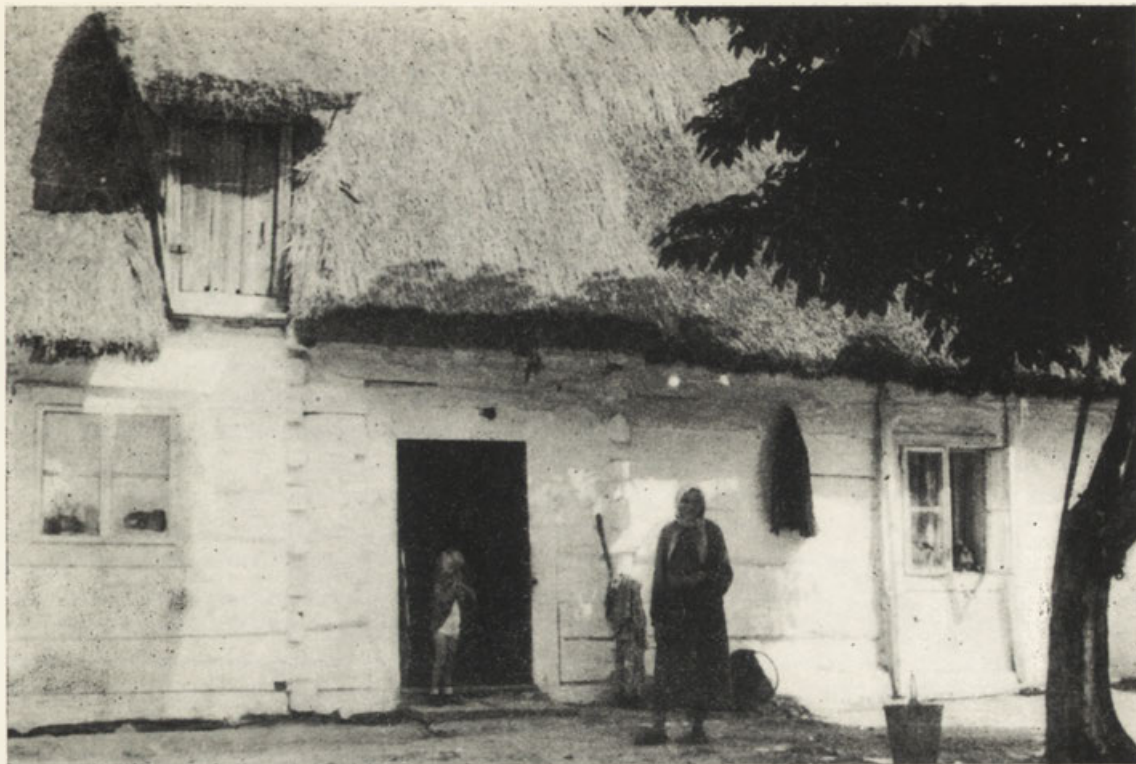
Fot. 7. Wieś Podbórz. Dom zbudowany w 1921 r. Dach dwuspadowy, duża sień, 3 izby.
