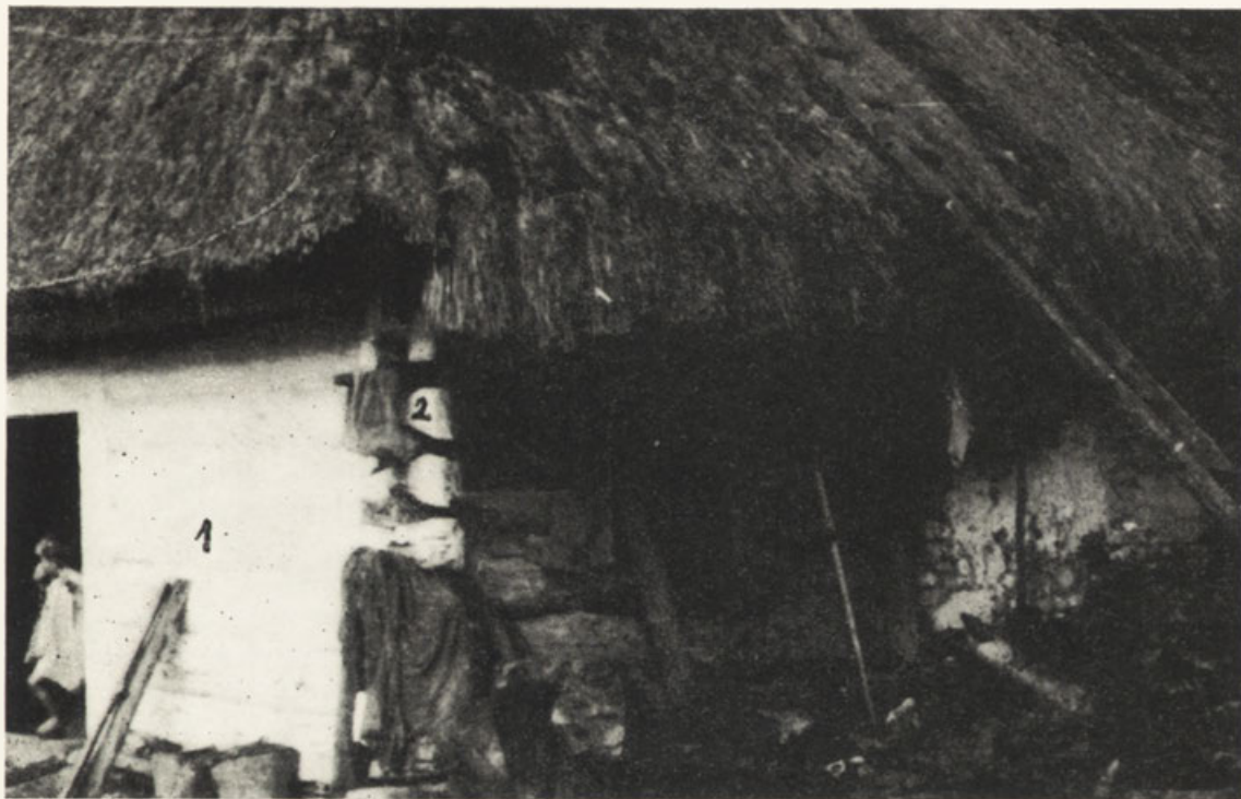
Fot. 1. Jeden ze starych budynków we wsi Paluchów Dom z 1863 r., zbudowany z grubych bali ciosanych (1). W konstrukcji wieńcowej zwęglowanie na jaskółczy ogon (2). Dom. Był strzechą o bardzo niskim okapie, dach czterospadowy. Okna i drzwi w r. 1914 zostały powiększone.
