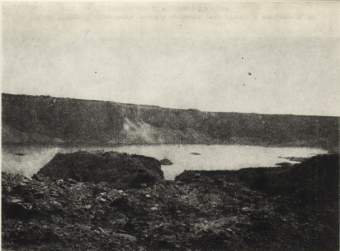
Fot. 1. Nieczynny kamieniołom „Wierzbica 1”. Wyciekająca na skutek rozcięcia poziomu wodonośnego woda utworzyła zbiornik. Na zdjęciu stan po długotrwałych opadach.
