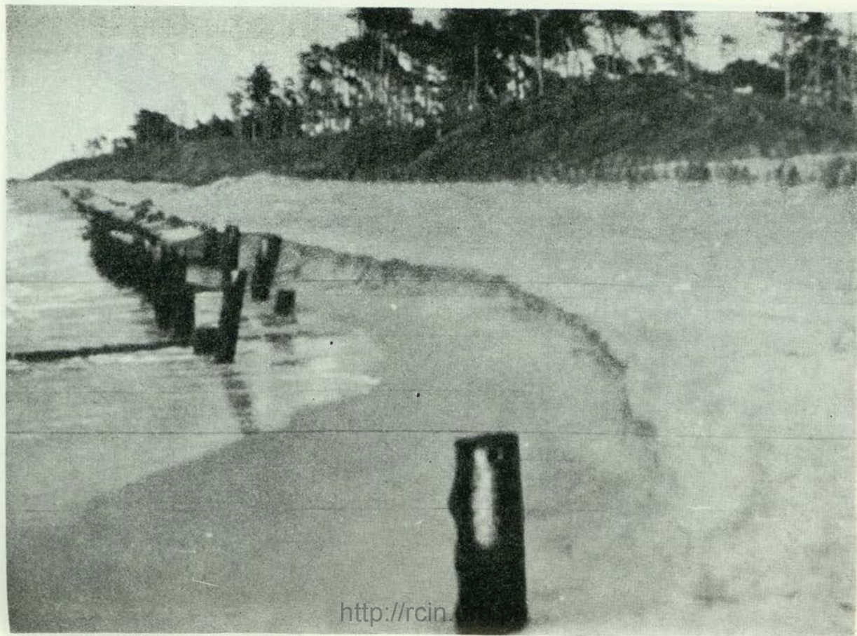
30. Jastarnia — Przerwa w wale brzegowym. Zniszczona opaska i ponownie odna-
