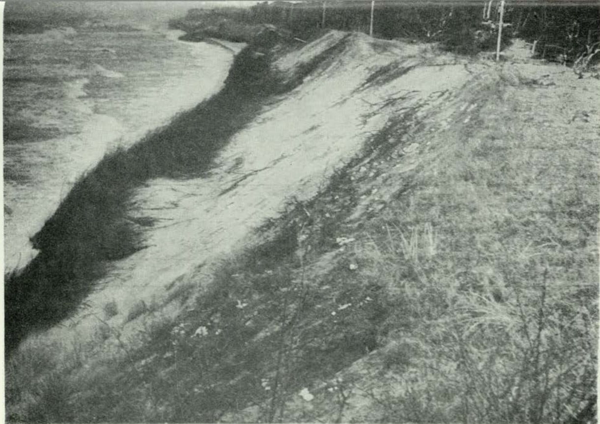
25. Jastarnia — Zanik plaży w czasie sztormu. Fale podmywają podnóże wału brzegowego. Widoczna abrazja i deflacja wału. 1960,
