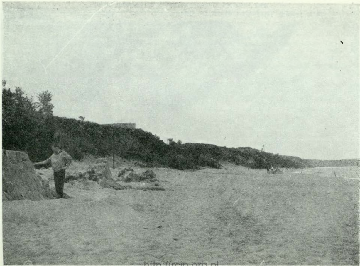
http://rcin.org.pl 20. Cetniewo — Zniszczona opaska betonowa. Widoczne cofnięcie się linii brzegowej poza opaskę. 1960.
