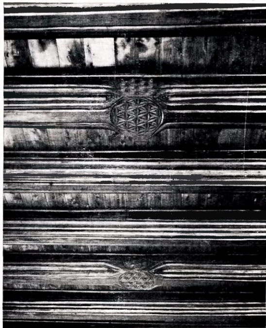
Fig. 23. Strop drewniany domu na Rynku I. 21.
