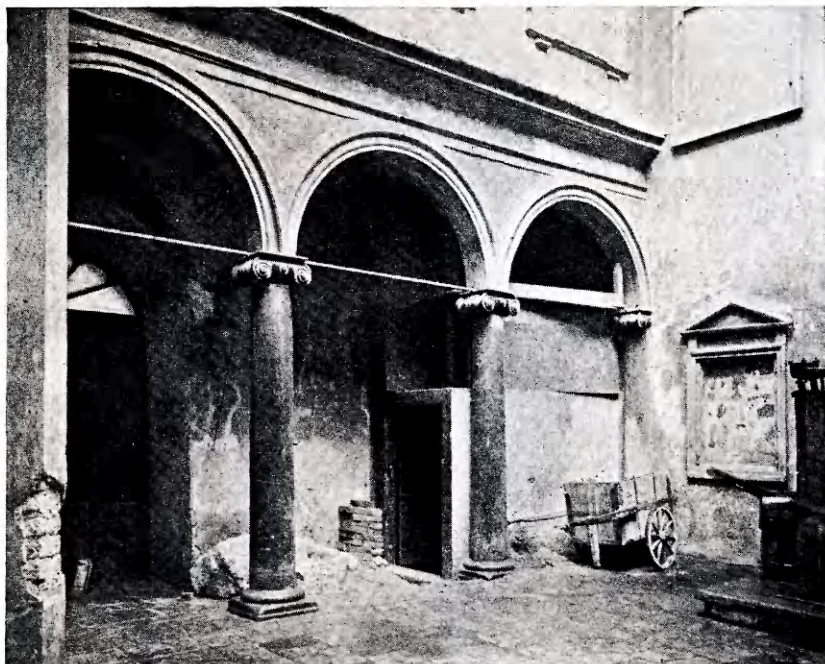
Fig. 22. Dawny widok dziedzińca domu na Rynku I. 21, róg ul. Brackiej.
