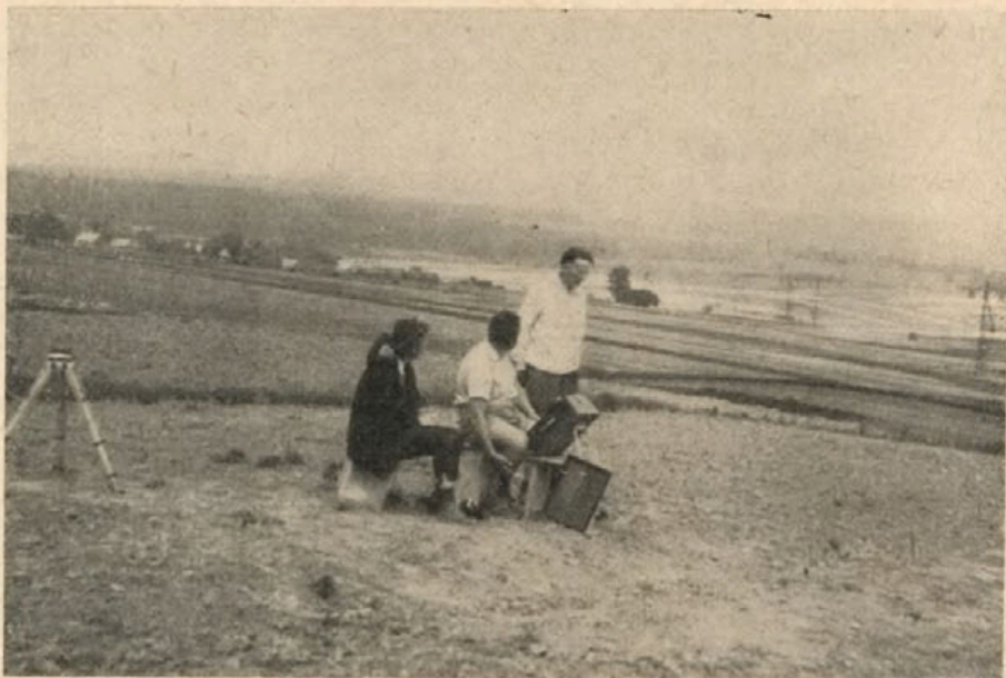
Ryc. 1. Nowa Słupia, pow. Kielce. Widok ogólny stanowiska 5. Wykonywanie pomiarów elektrycznooporowych aparaturą „Elektrisk Malmletning AB”
