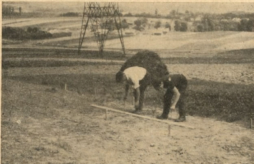
Ryc. 4. Nowa Słupia, pow. Kielce, stan. 5. Fragment stanowiska z siatką punktów badawczych i zastosowanym szablonem z wyznaczonymi rozstawami AB i MN sondowań pionowych
