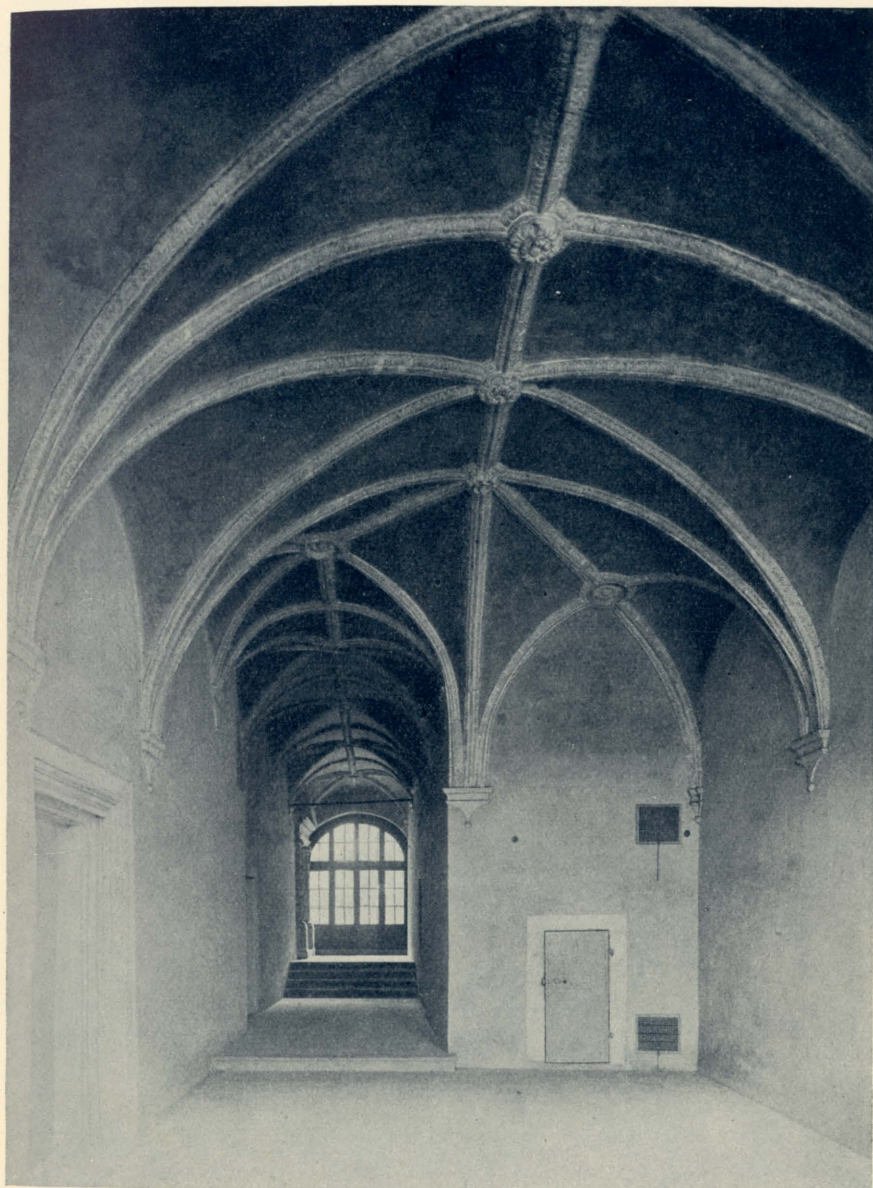
Вестибюль дома Собьскаго.
