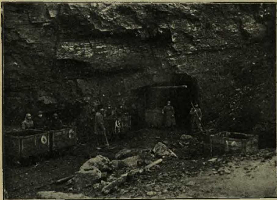
Z Dąbrowy Górniczej. — Wywożenie węgla z szybu wagonikami.
