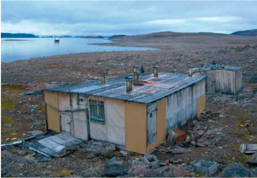
Fot. 3. Stacja „Haudegen” w latach 1980.
