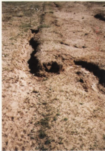
Fot. 9. Faza inicjalna koryta rzecznej w linii drogi na obszarze Gobi.
