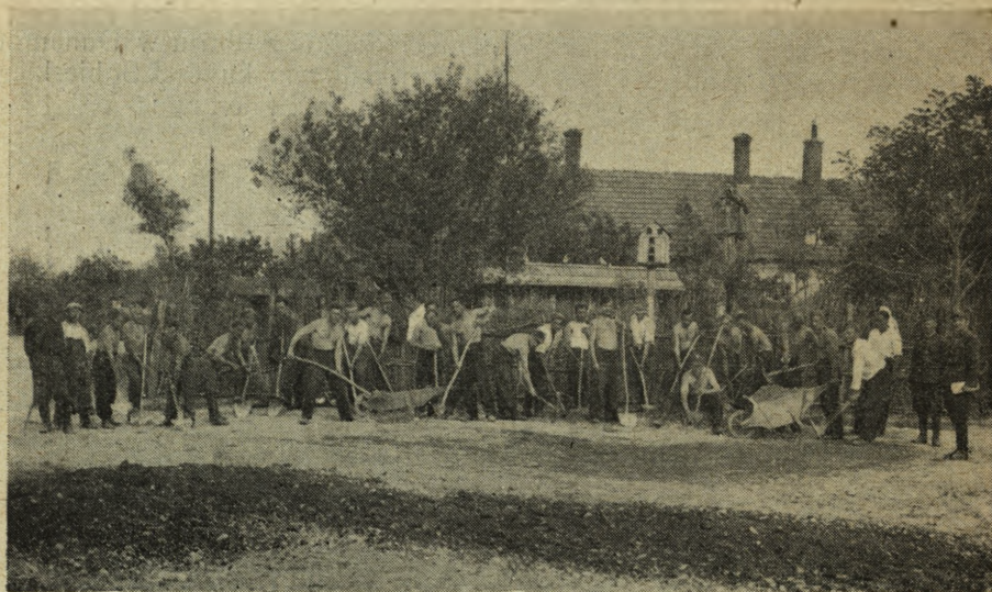
Przy budowie szosy w Rajce.
