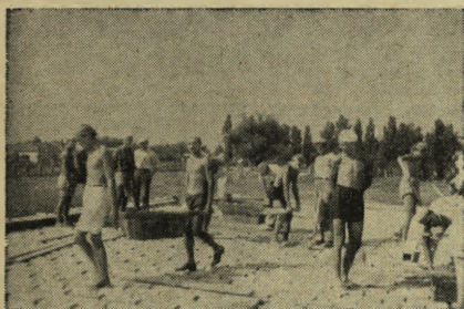
Młodzież z Balatonboglár przy pracach budowlanych.
