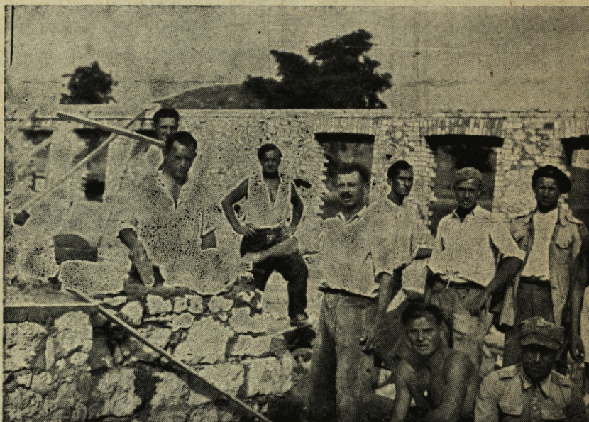
Internowani przy pracach budowlanych w Ujdöröpuszta.
