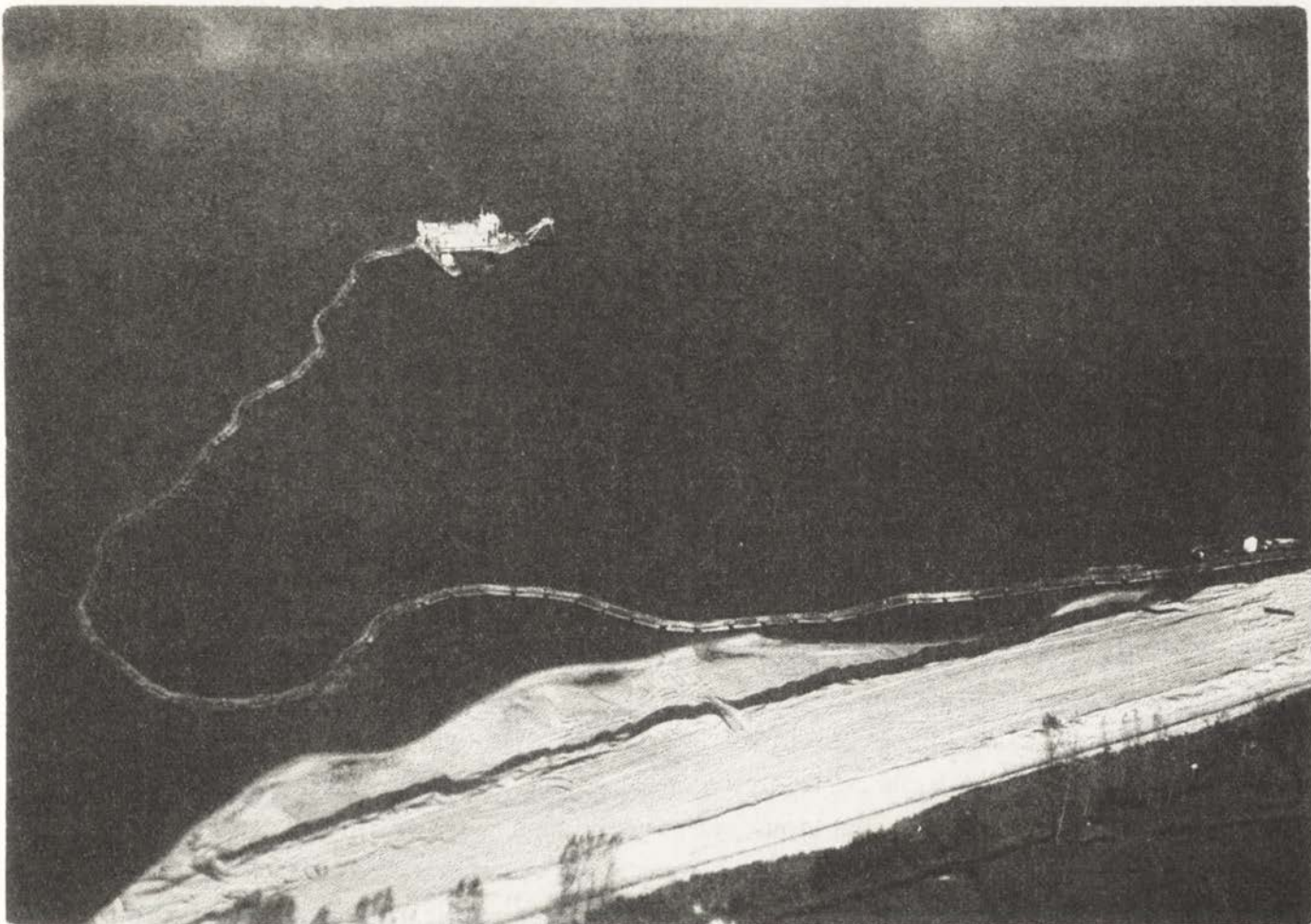
Fot. 4. Prace bagrownicze rumowiska wleczonego Wisły akumulowanego w górnej części zbiornika włocławskiego Dredging works of the bed material accumulated in upper part of Włocławek reservoir
