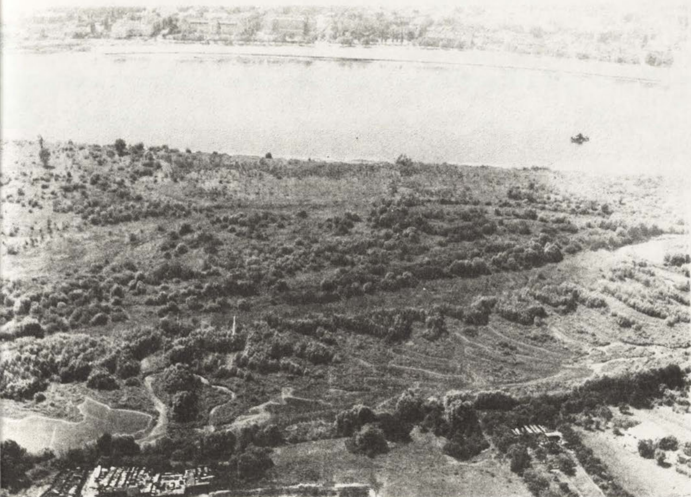
Fot. 6. Nowo tworzony poziom zalewowy poniżej mostu drogowego we Włocławku (prawy brzeg), będący efektem procesów erozyjnych poniżej stopnia wodnego we Włocławku. Fot. lipiec 1988 r.
