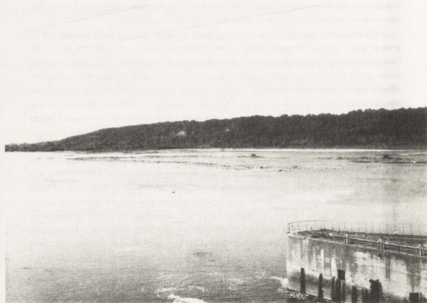
Fot. 5. Odcinek erozyjny koryta Wisły poniżej stopnia wodnego Włocławek (bezpośrednie sąsiedztwo zapory czołowej) o dnie pokrytym głazami (bruk). Fot. lipiec 1988 r. Erosive segment of Vistula channel downstream from the Włocławek dam (close neighbourhood of the dam), of a bottom covered by stones (a pavement). Photo July 1988
