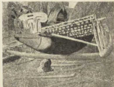
(c) Catamaran na brzegu. Reja spoczywa na łądzie po prawej stronie; jest ona połączona z łodzią za pomocą układu prętów, z których górne stanowią rodzaj pokładu. (Z książki Malinowskiego „Argonauts of the Pacific “).
