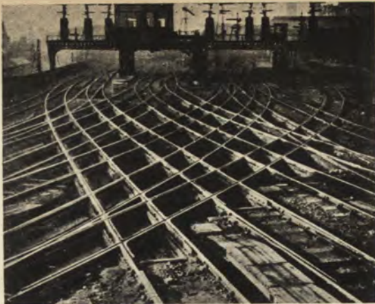
(a) Rysunek pokazuje, w jakich wypadkach wskazane jest zastosowanie stali miękkiej — manganowej.
