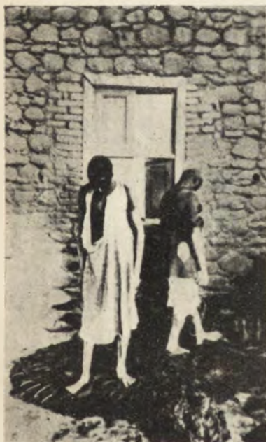
(b) Afrykańczycy podczas udeptywania gliny dla nadania jej jednolitego składu i uwolnienia od pęcherzyków powietrza.
