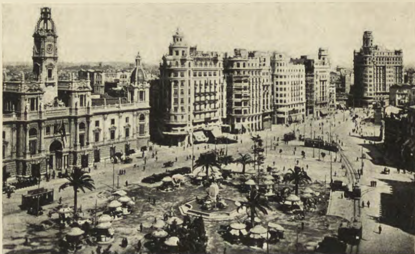
VALENCIA: AVENIDA DE BLASCO IBANEZ — WIELOPIETROWE GMACHY NIE TWORZA JEDNOLITEJ SYLWETY, ALE UJAWNIAJĄ POTEŻNĄ WIZJĘ WSPÓŁCZESNOŚCI
