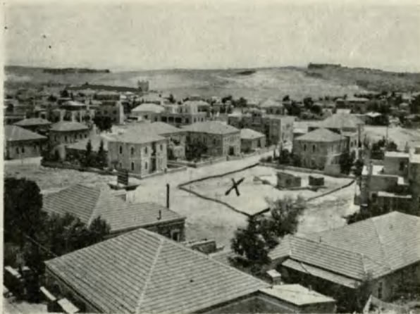
Teren Nowego Domu P. w Jerozolimie z wieży wł. szpitala.
