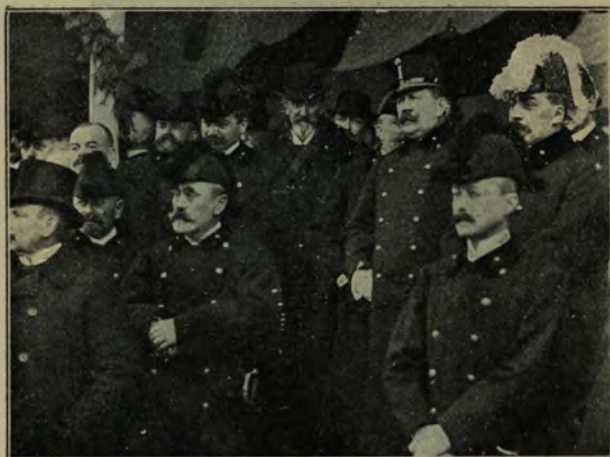
Uroczysta inauguracja budowy kanałów w Brzeźnicy.
