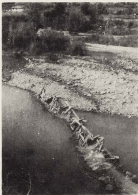
Fot. VI-1-1. Prymitywny jaz w korycie rzeki (R. Aconcagua).
