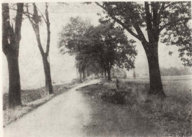
Ryc. 20. Uszkodzona szosa w obrębie osuwiska w Marciszowie.
