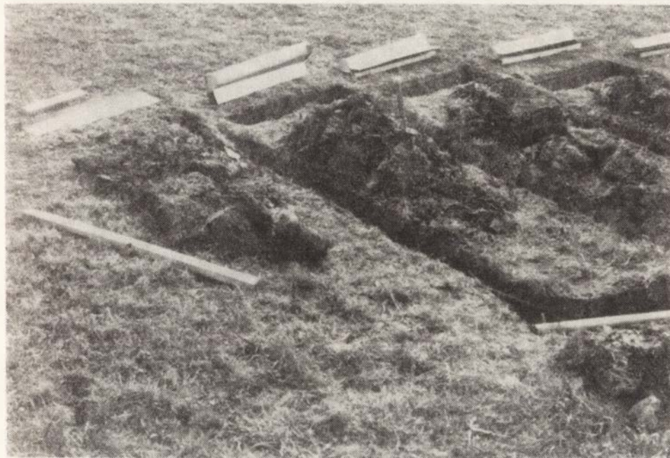
Fot. 3. Rynny do pomiarów spływu powierzchniowego na stoku „Technikum NW” Phot. 3. Troughs for surface runoff measurements on „Technikum NW” experimental slope
