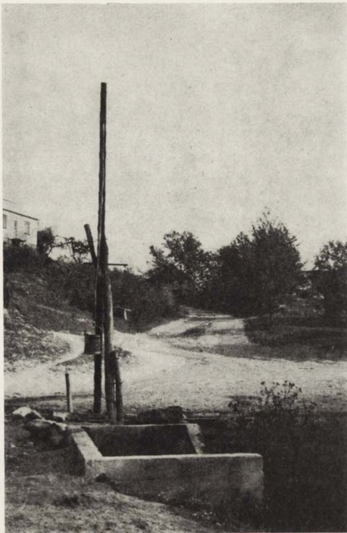
Fot. 3. Źródło w Orchowcu w pow. Krasnystaw jest podstawą zaopatrzenia w wodę wsi. Przykład wyjątkowo tylko spotykanego przy źródle żurawia
