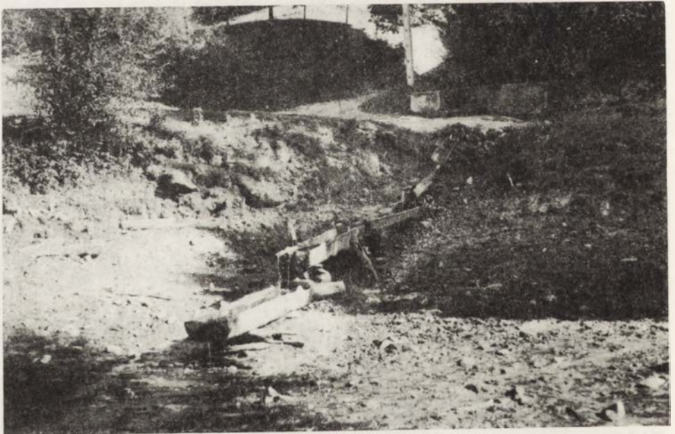
Fot. 12. Jeden z wypływów wody źródlanej w Krynicy w pow. Krasnystaw. Na dalszym planie widoczny zbiornik do poboru wody pitnej
