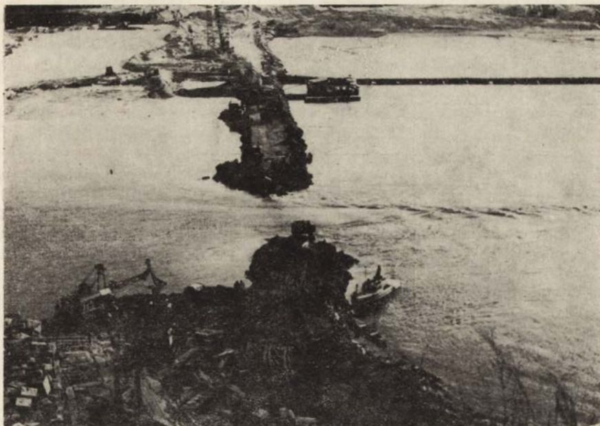
Fot. 2. Moment przegrodzenia koryta Wisły zaporą we Włocławku (fot. „Hydroprojekt” we Włocławku)
