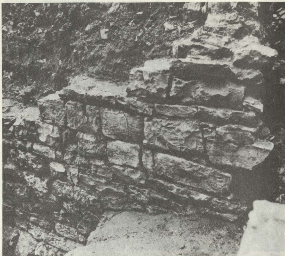
Ryc. 3. Kraków-Wawel, rejon XIV przed pdn. elewacją pałacu królewskiego. Zewnętrzne, ciosowe lico fundamentu (!) zachodniej ściany ryzalitu budowli romańskiej
