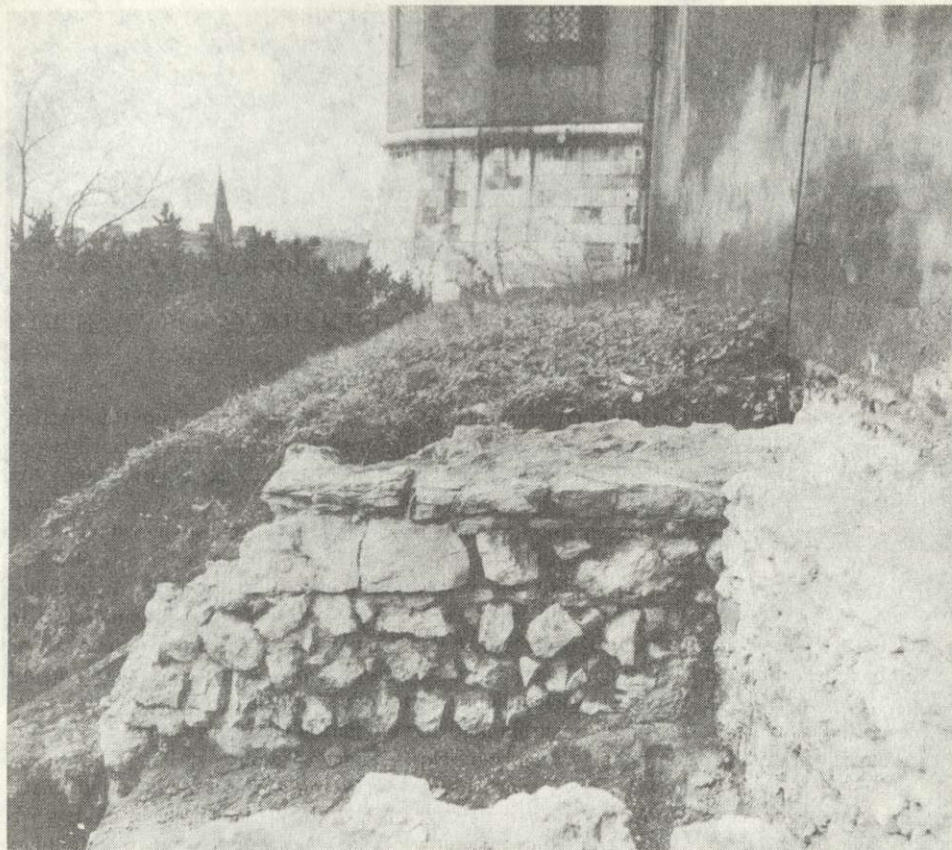
Ryc. 2. Kraków-Wawel, rejon XIV przed pdn. elewacją pałacu królewskiego. Wewnętrzne lico wschodniej ściany budynku romańskiego przybudowanego do „sali o 24 słupach”
