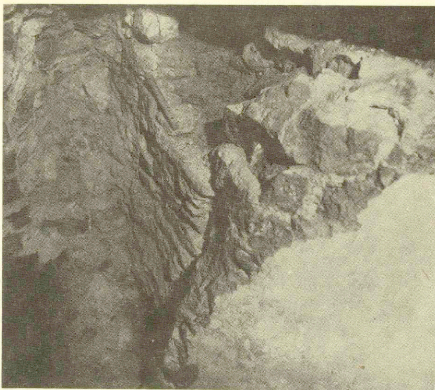
Ryc. 4. Kraków-Wawel, rejon IV, kotłownia pod kapitularem. Fragment zewnętrznego lica rotundy odsłonięty w sondzie architektonicznej nr 1
