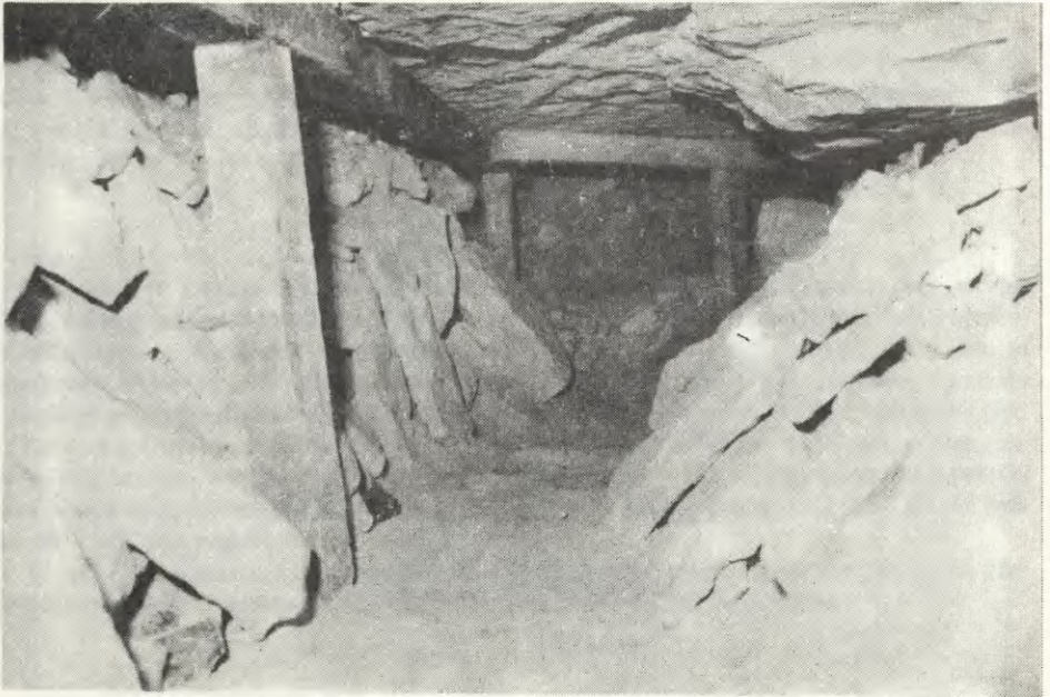
Ryc. 15. Licowana obustronnie płytami część chodnika IIa Part of gangway IIa, faced on both sides with slabs
