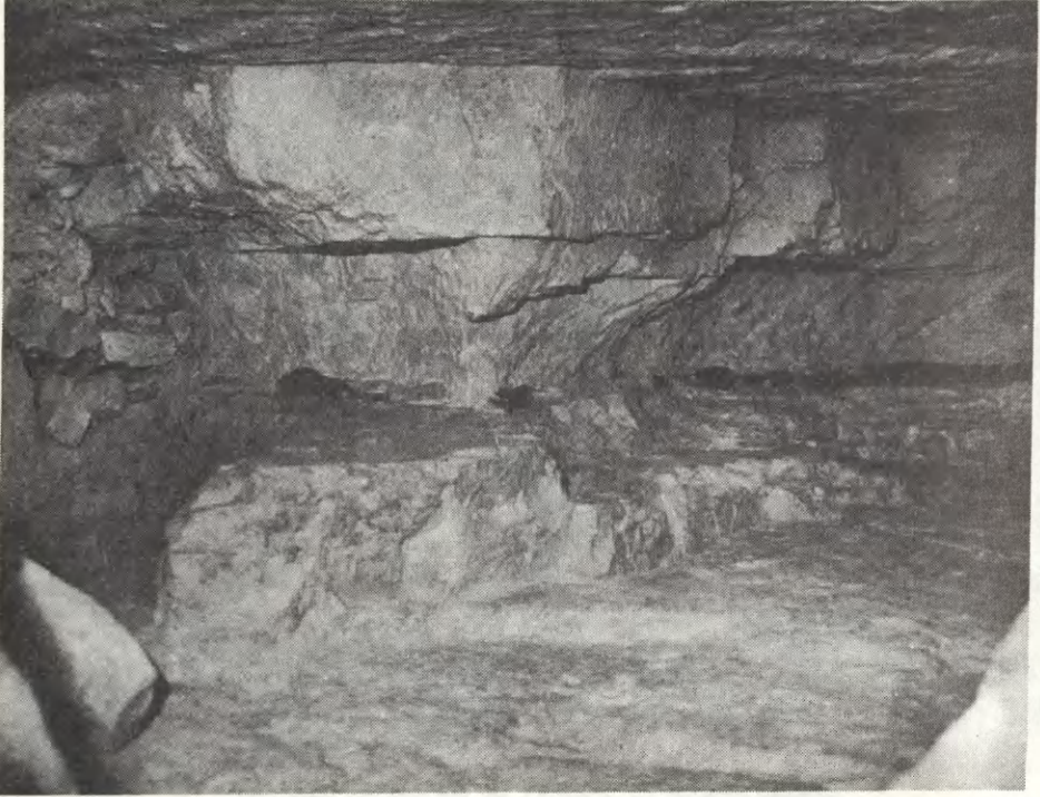
Ryc. 21. Ostroga – forma ociosu manifestująca zetknięcie się dwóch frontów robót górniczych Spur – form of the side wall manifesting the meeting point of two ends of mining works
