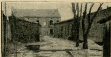
WIDOK NOWO WYBUDOWANEJ FABRYKI OD STRONY UL. MŁYNARSKIEJ.
