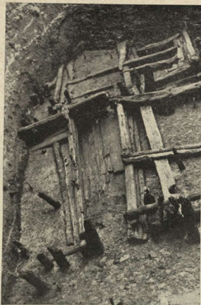
Ryc. 17. Opole-Ostrówek. Przejście między domami 66 i 68 B. U góry konstrukcje domu 68 B
