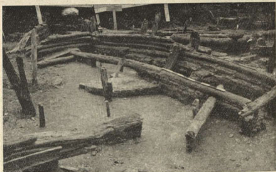
Ryc. 7. Opole-Ostrówek. Dom 64 E III z legarem pod podłogę, przechodzącym nad paleniskiem
