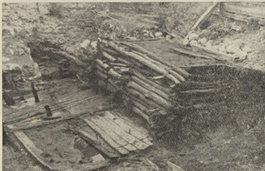
Ryc. 10. Opole-Ostrówek. Konstrukcja „przywala” z odsłoniętą ścianą boczną
