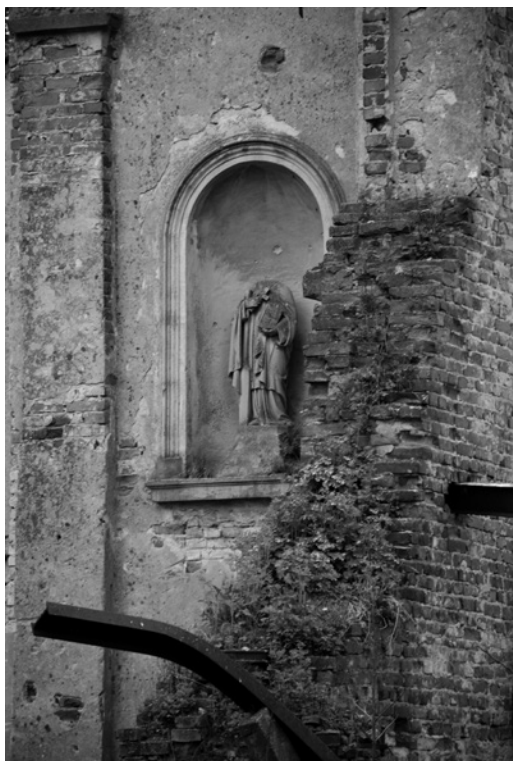
Fragment ruin pałacu w Kołtowie. Fot. Katarzyna Łoza
