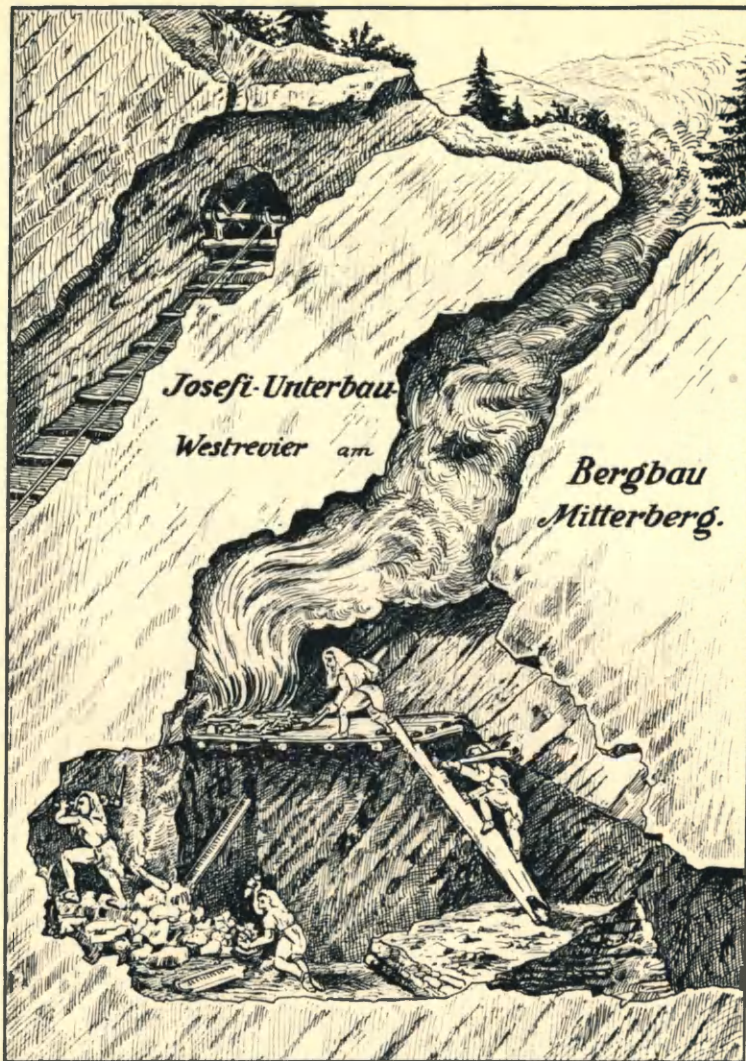
129. Rekonstruiertes Bild eines Bergwerks der Bronzezeit. Rechts Abbaufeld mit Feuerbühne, links Förderstollen mit Handhaspel. Gez. von Pirchl
