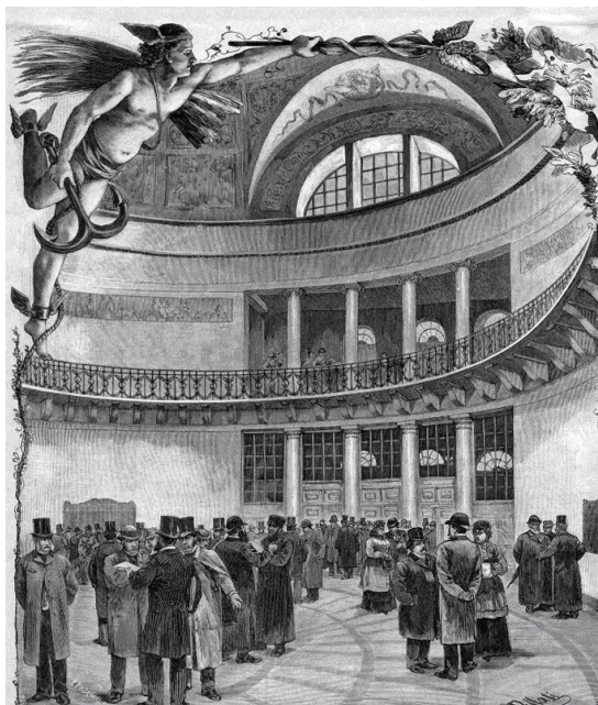
Ksawery Pillati: Wnętrze dawnej sali giełdowej byłego Banku Polskiego. J. w. s. 40
